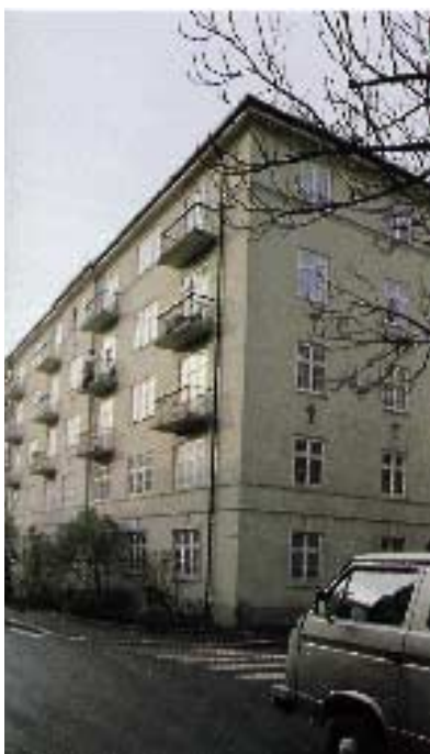
Felleskjøkkenhus i Gabels gate.
