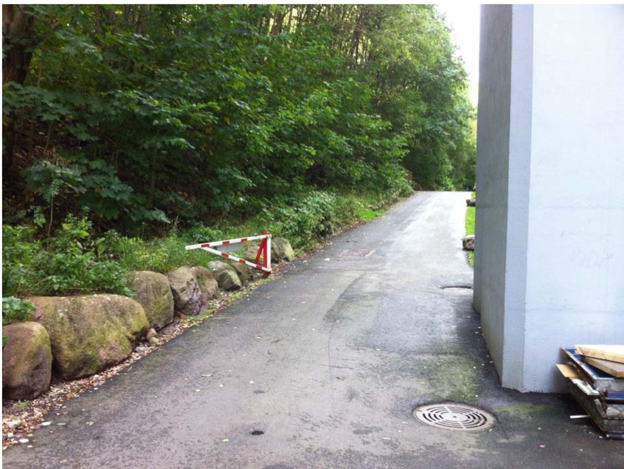
Bilde 4: Nordlige port til garasjeanlegg Grefsen Terrassehus
