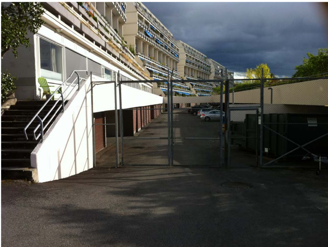
Bilde 3: Nordlige port til garasjeanlegg Grefsen Terrassehus
